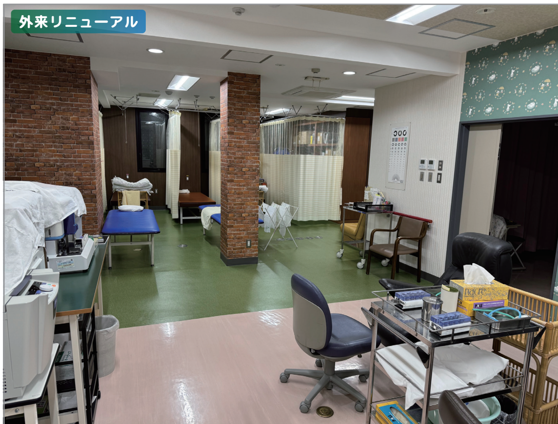
1階廊下の壁を撤去し、発熱外来、処置、ベッドスペースを拡充しました。
