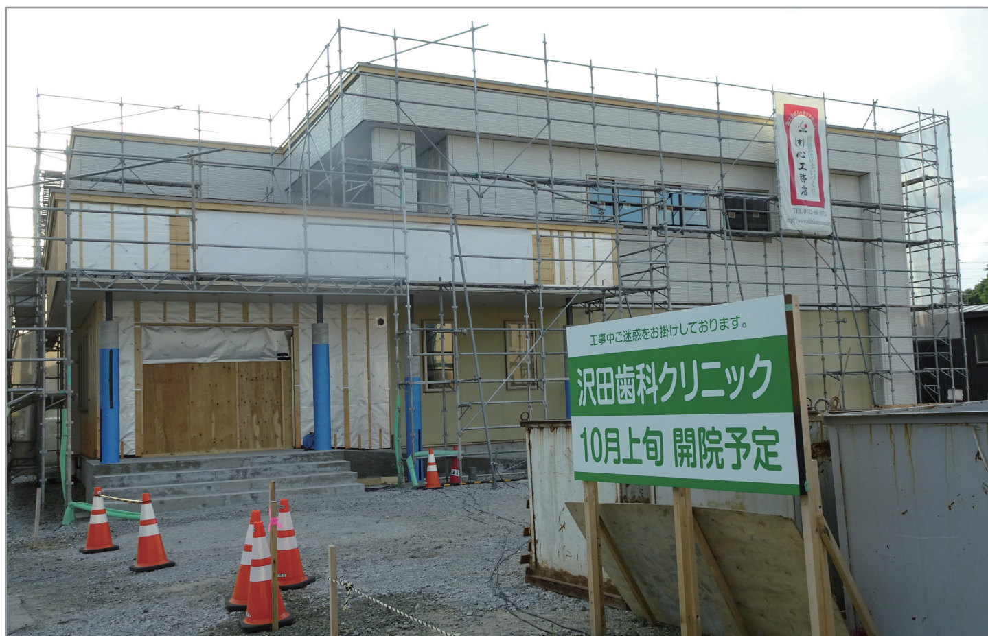
工事中の沢田歯科クリニック
