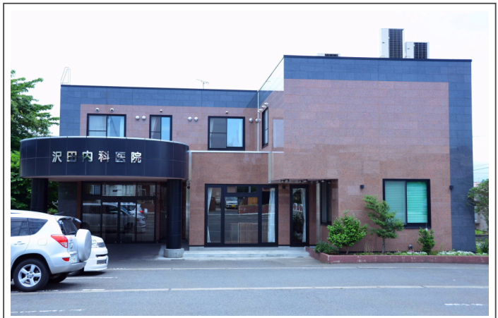
中央が増築部分です。外壁は光沢があり反射します。
